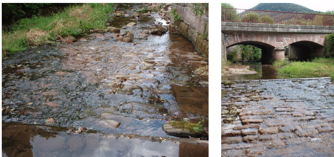
Figure 12 : Radier en aval proche du barrage du Rabodeau
